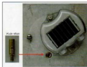
アンカーボルトの叩き込みと固定
